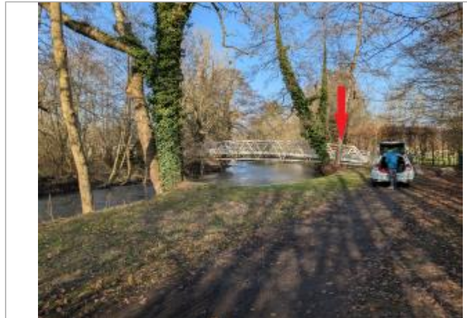
Vue depuis l'aval de la rive gauche.
