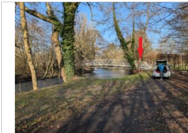
Vue depuis l'aval de la rive gauche.
