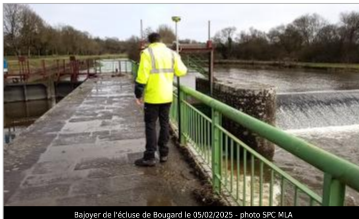
Bajoyer de l'écluse de Bougard le 05/02/2025 - photo SPC MLA
