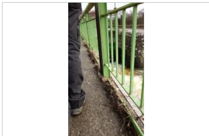
Relevé de la laisse d'inondation sur le bajoyer
