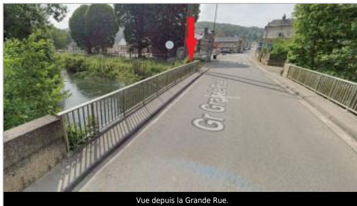
Vue depuis la Grande Rue.
