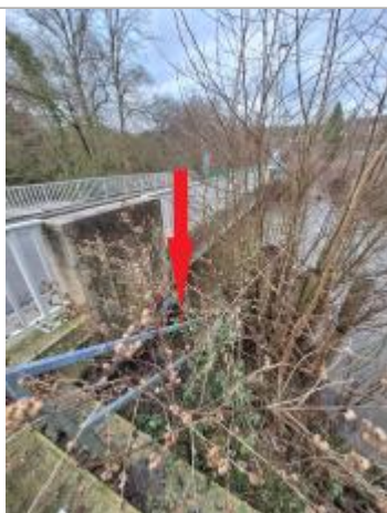
Laisse de crue peinte sur le pilier du pont à -2.44/hauteur du muret.
