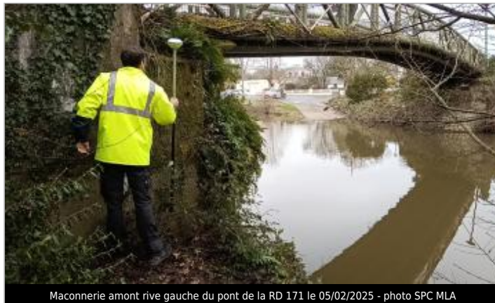
Maconnerie amont rive gauche du pont de la RD 171 le 05/02/2025 - photo SPC MLA
