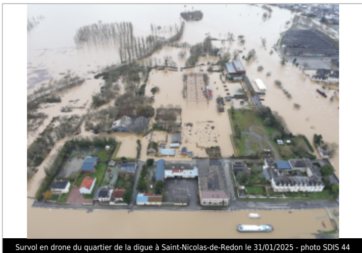
Survol en drone du quartier de la digue à Saint-Nicolas-de-Redon le 31/01/2025 - photo SDIS 44
