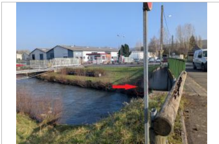
Vue depuis le pont de la rue Transières.
