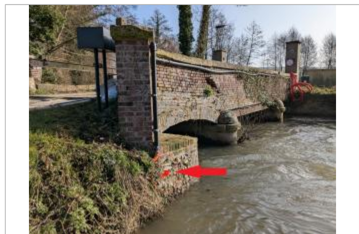
Laisse de crue à - 85 cm/macaron IGN (41.718 m)
