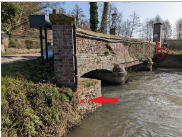
Laisse de crue à - 85 cm/macaron IGN (41.718 m)
