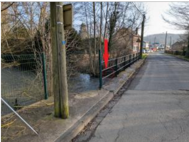
Laisse de crue sur le haut du mur de la buse (Photo SYMA).
