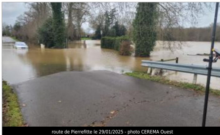
route de Pierrefitte le 29/01/2025 - photo CEREMA Ouest
