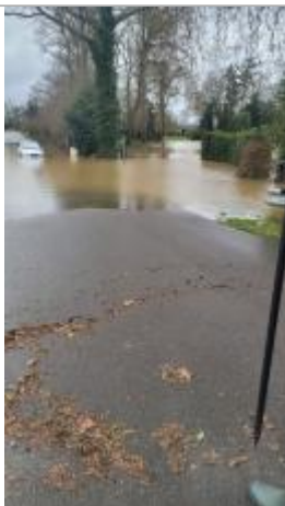
Laisse d'inondation sur la chaussée
