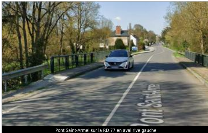
Pont Saint-Armel sur la RD 77 en aval rive gauche
