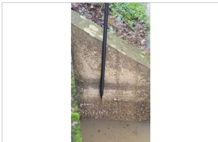
relevé n°1 sur la maçonnerie du pont le 29/01/2025 - photo CEREMA Ouest
