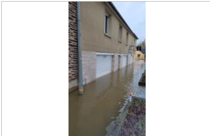
Restaurant au n°6 rue de Nantes - RD837 le 29/01/2025 - photo CEREMA Ouest
