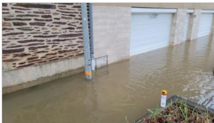
Lampadaire devant le restaurant au n°6 rue de Nantes - RD837 le 29/01/2025 - photo CEREMA Ouest
