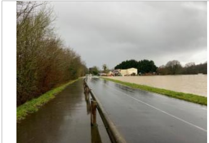
Piste cyclable le long de la RD837 le 27/01/2025 à 12:14 - photo DDTM 35
