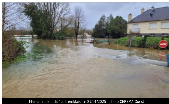
Maison au lieu-dit "Le tremblais" le 29/01/2025 - photo CEREMA Ouest
