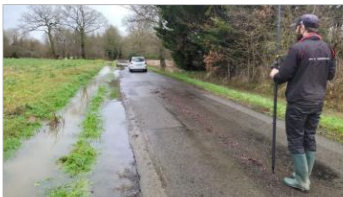
Chaussée sur la route de la rivière le 29/01/2025 - photo CEREMA Ouest
