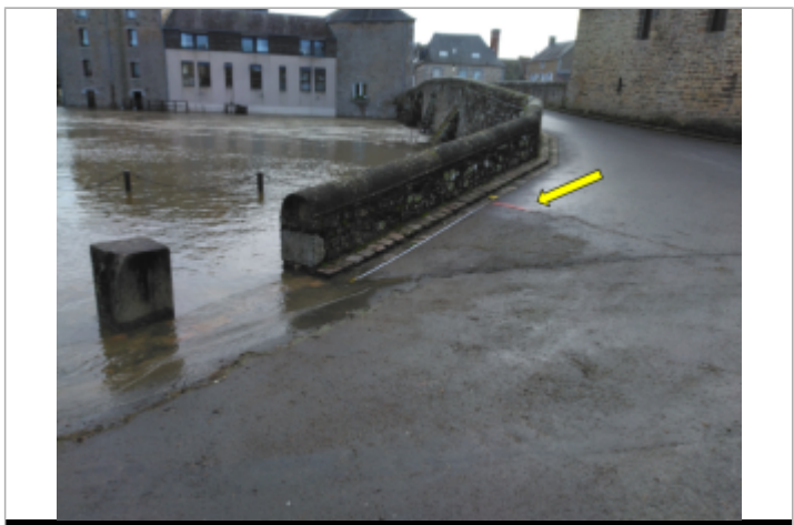
LC dépôt de végétation à 3,35m du bout du trottoir, longitudinalement.
