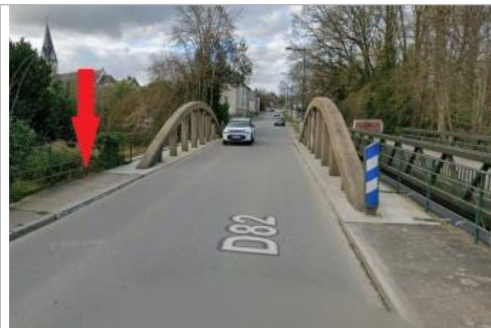
Pile amont rive gauche du pont de la RD82
