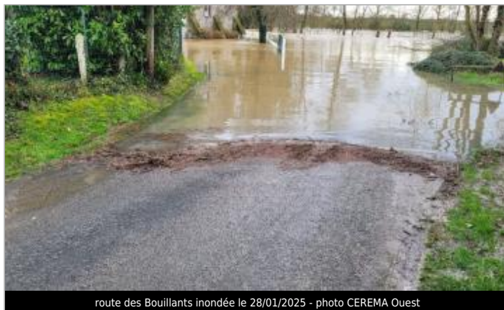
route des Bouillants inondée le 28/01/2025 - photo CEREMA Ouest
