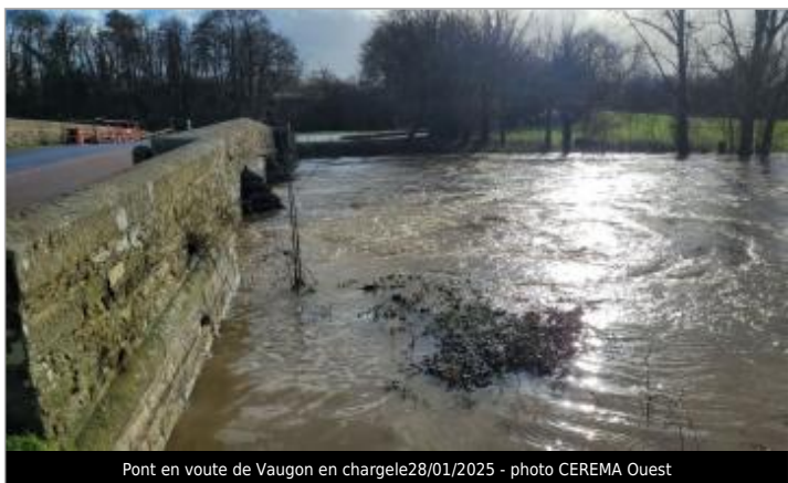
Pont en voute de Vaugon en charge le 28/01/2025 - photo CEREMA Ouest
