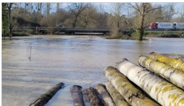
Vue du pont de la RD 173 du pont de Vaugon le 28/01/2025 - photo CEREMA Ouest
