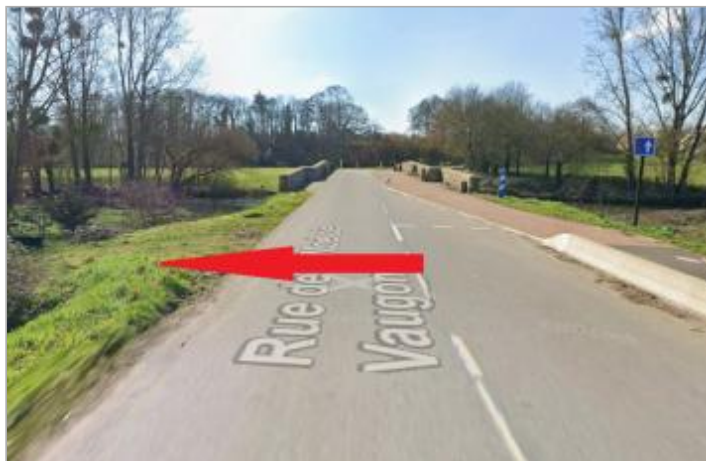
Rive droite et en amont du pont de Vaugon
