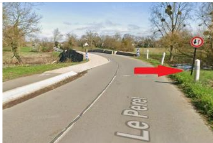
Début du chemin en rive gauche et en aval du pont de Vaugon
