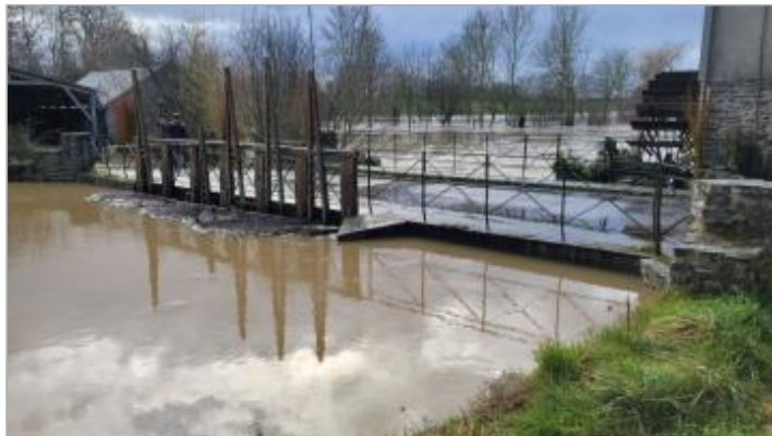
Vannage du moulin de Tertron le 28/01/2025 - photo CEREMA ouest
