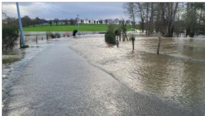
route du moulin de Tertron le 28/01/2025 - photo CEREMA Ouest
