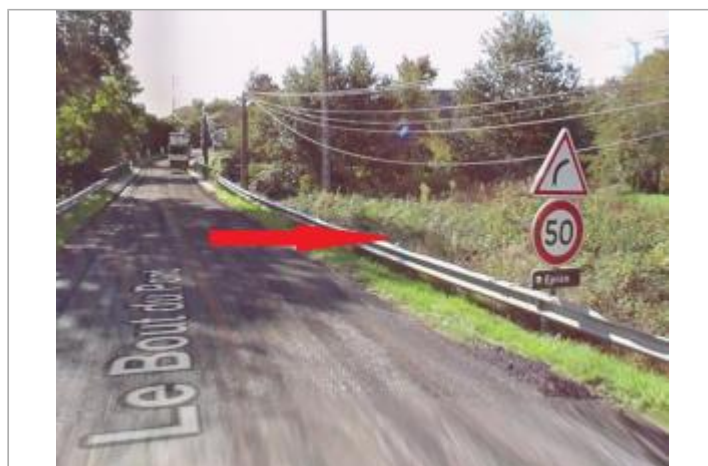
Bord de la RD 101 en aval du pont d'Epron
