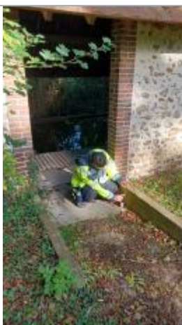
Laisse de crue à -10 cm/haut du muret.
