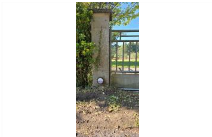
Pilier gauche du portail d'entrée à l'étang rue du Moulin de Pallueau à Estouy
