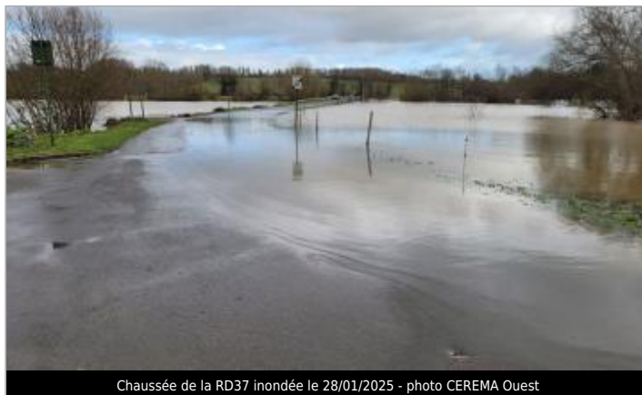
Chaussée de la RD37 inondée le 28/01/2025 - photo CEREMA Ouest
