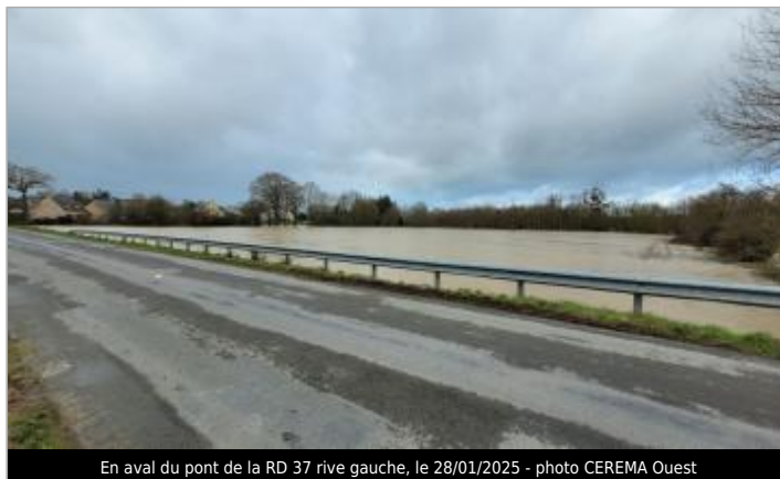
En aval du pont de la RD 37 rive gauche, le 28/01/2025 - photo CEREMA Ouest
