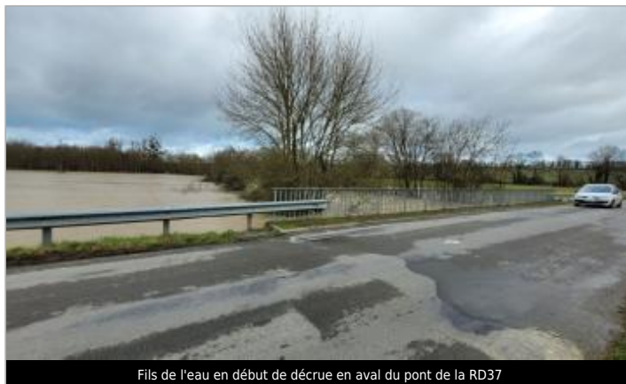
Fils de l'eau en début de décrue en aval du pont de la RD37
