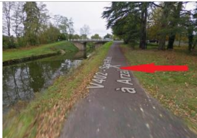
Chemin de halage en aval du pont de la RD36 à Mons
