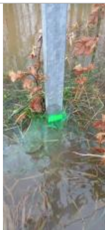
Poteau sans issue vers la station dépuraton et le village de la Robinais
