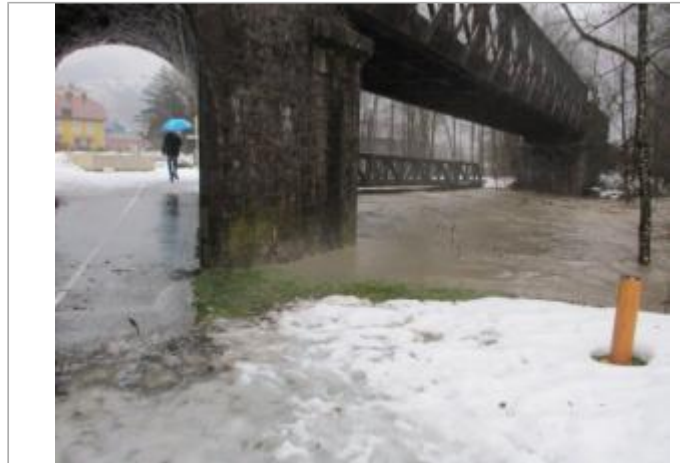
pont SNCF et pont la piste cyclable
