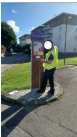
Laisse de crue à 114.5 cm/sol.
