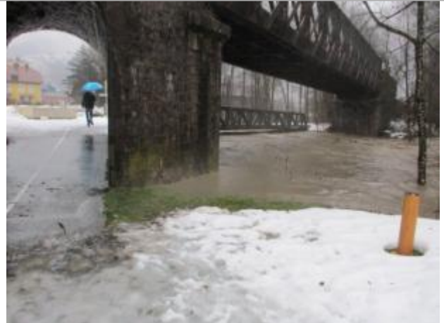
pont SNCF et pont la piste cyclable
