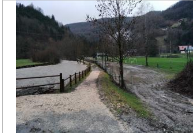
Base de loisir au droit du stade de foot, Queige
