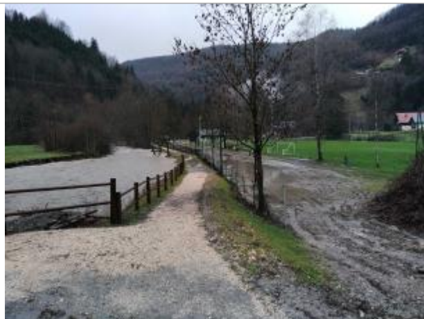
Base de loisir au droit du stade de foot, Queige
