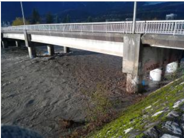
Photo prise le 13 décembre à 15h, vue de la rive gauche en aval du pont du Mirantin
