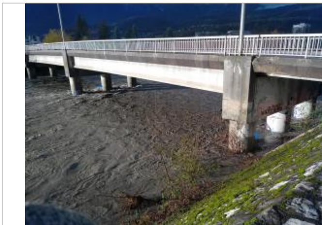
Photo prise le 13 décembre à 15h, vue de la rive gauche en aval du pont du Mirantin
