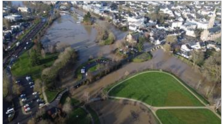
Vue aérienne de l'inondation du 28/01/2025 - photo CEREMA Ouest
