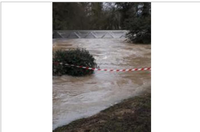
Passerelle du parc Dézerseul inondée le 28/01/2025 - photo CEREMA Ouest
