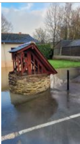
Puit sur le parking de la rue de l'ancien relais
