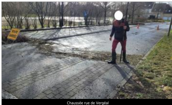
Chaussée rue de Vergéal
