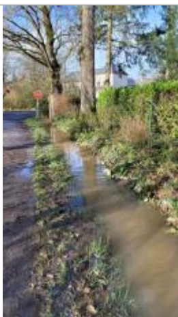
Relevé de la laisse d'inondation sur le chemin vers pont Amelin
