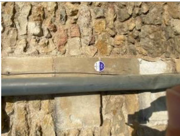
Vue sur la mur support du macaron
