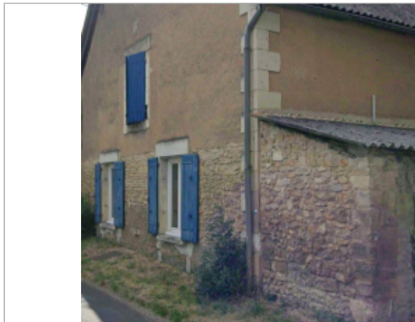
Vue sur la façade de l'habitation © Google street view
