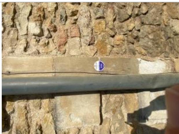
Vue sur la mur support du macaron
