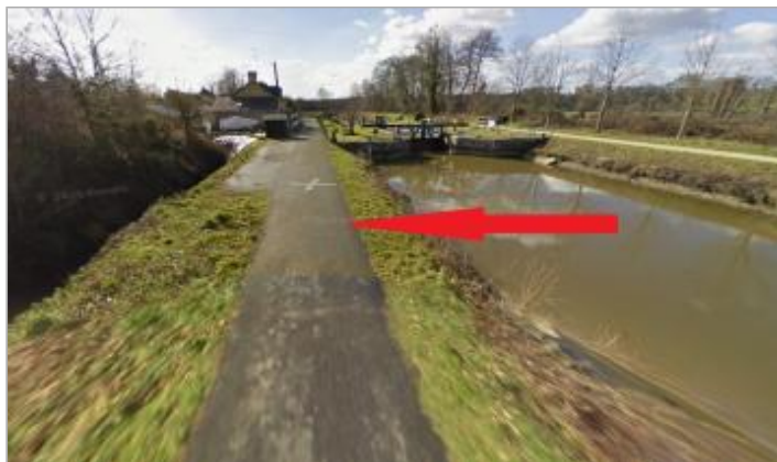
Chemin de halage en amont de l'écluse du Gacet
